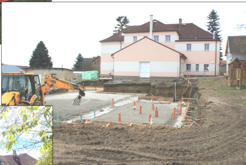
Příprava základové desky
