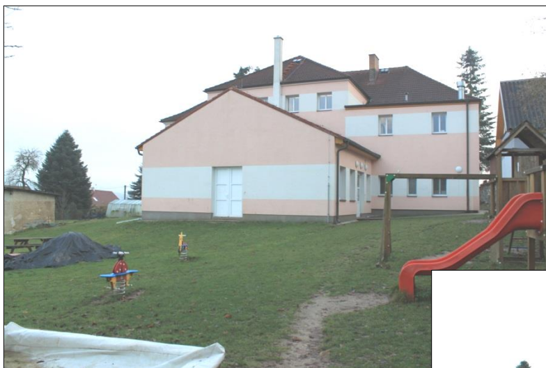
Prostor před realizací přístavby
