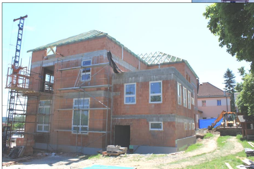
Stavba před pokládkou střešní krytiny
