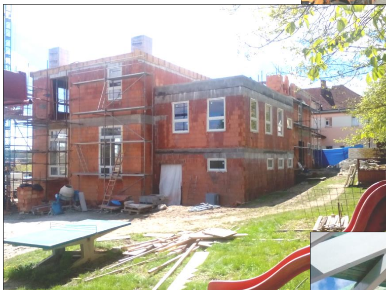
Vybudování tělocvičny, 1. podlaží a osazení oken
